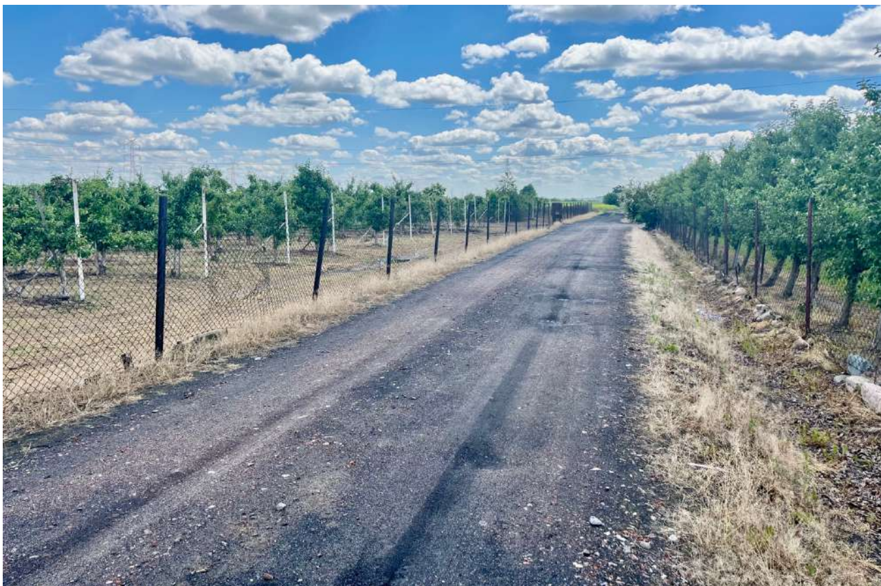
Fot. 3. Obszar sadów sąsiadujących z działkami objętymi wnioskiem. Zdjęcie 04.06.2026 r.
