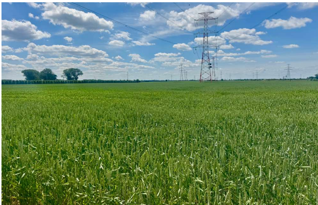
Fot. 5. Obszar planowanej inwestycji, widok na działki objęte wnioskiem. Zdjęcie 04.06.2026 r.
